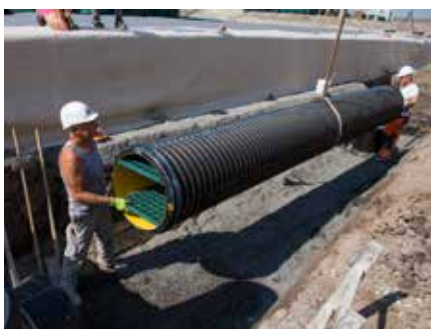
2. Sedimentationsrohr in Einbauposition bringen
