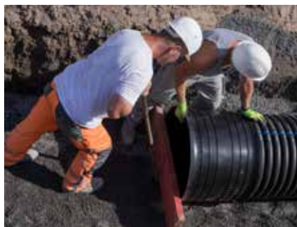
4. Montage Sedimentationsrohr
