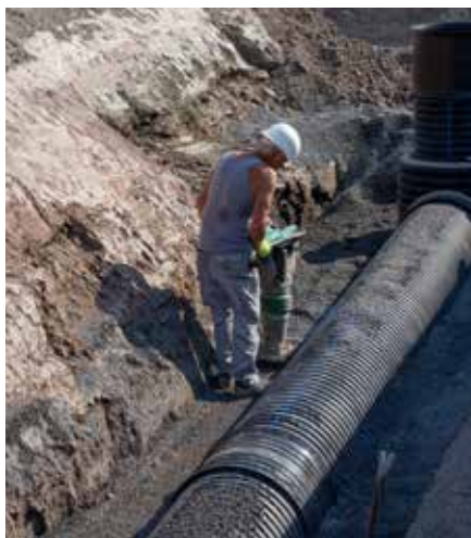
Verdichten der Seitenverfüllung
