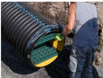
3. Dichtring mit Gleitmittel einstreichen
