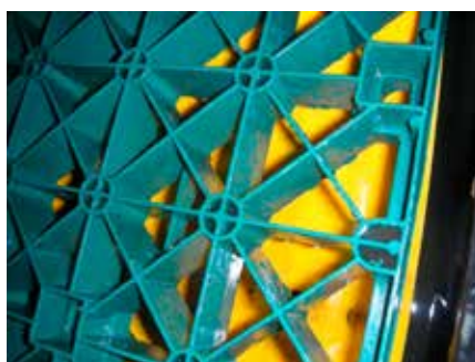
Gereinigte, rückstandsfreie Anlage, hier im Bereich Strömungstrenner
