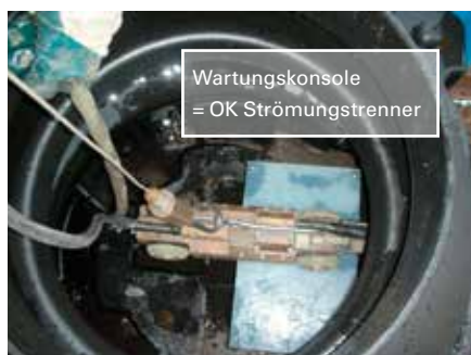
Kontrolle des Spülerfolges mit Dreh-Schwenkkopf-kamera, Kamera auf der Wartungskonsole im Startschacht einer SediPipe L - Anlage
